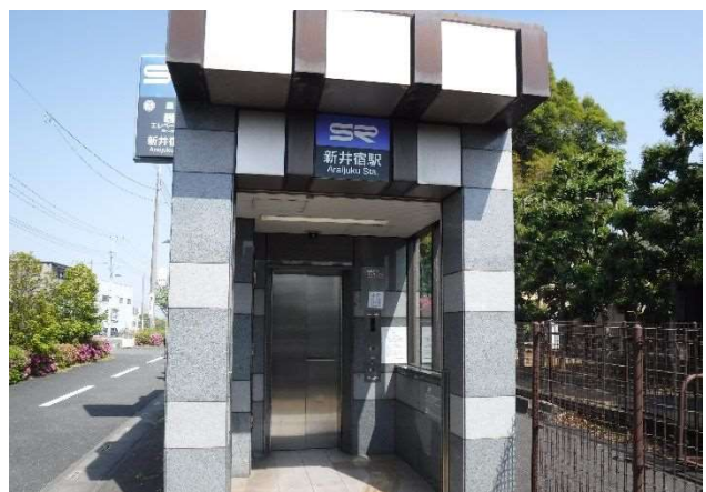
写真 3 : 新井宿駅出入口 (エレベーター)
