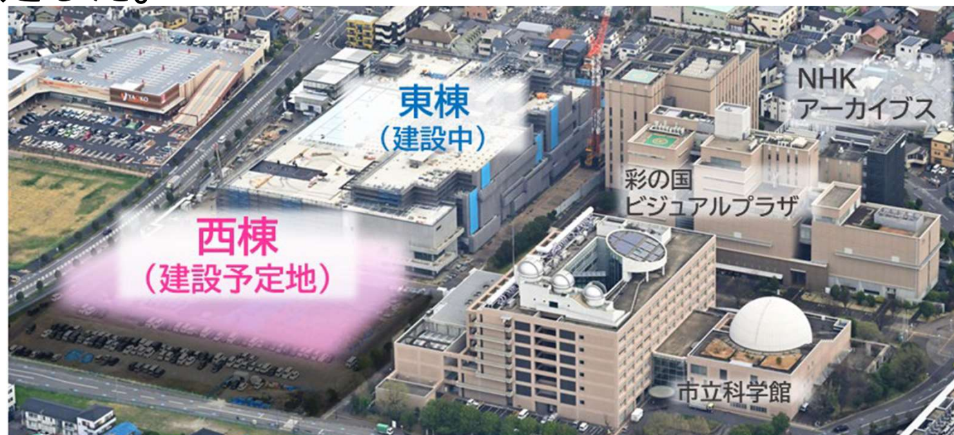
西棟建設予定地(2025年4月基本計画変更資料より、東棟は2026年3月建物完成)
