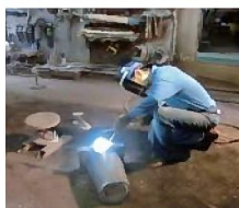
溶接作業の様子
