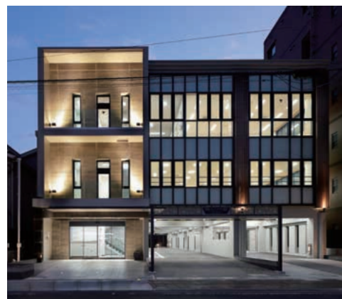
最近の当社の施工実績から。鳩ヶ谷公民館新築。
