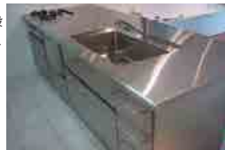
システムキッチン 業務用をアレンジして一般住宅に設置しました。 ガスコンロは家庭用です。ビルトイン洗浄機付。
