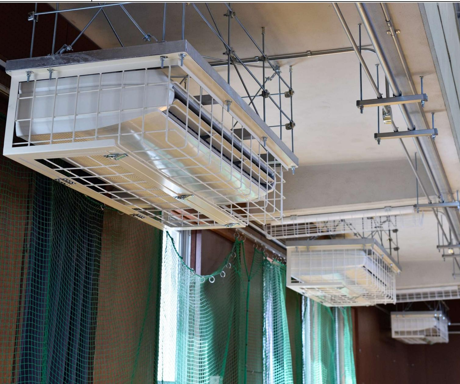
ボール等が衝突した際のエアコン本体の破損・故障を防ぐための製品です。
