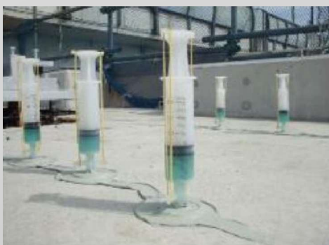
従来工法 【ひびわれ補修（低圧注入）】
