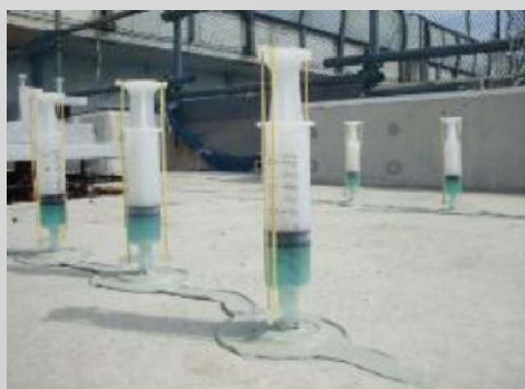
従来工法 【ひびわれ補修（低圧注入）】
