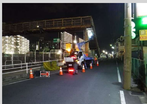
従来点検方法 【高所作業車】
