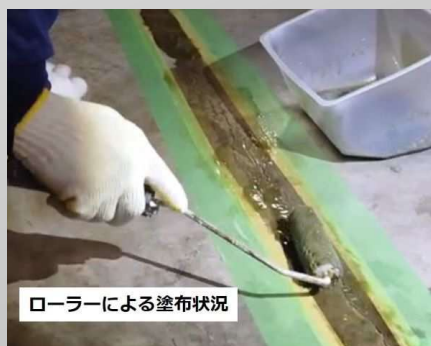
新工法 【ひびわれ補修（塗布型）】 NETIS 登録番号：QS-230015-A
