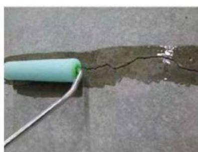
塗布・浸透型ひびわれ補修材
