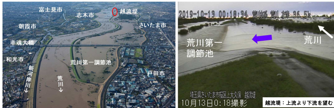
【令和元年度東日本台風時の洪水流入状況】
