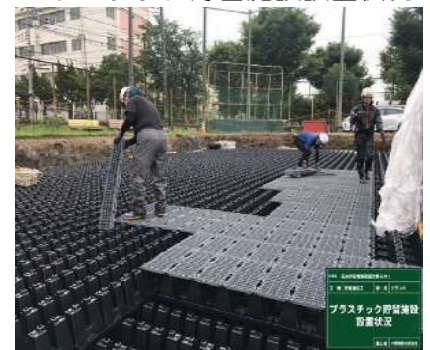
プラスチック貯留施設設置状況
