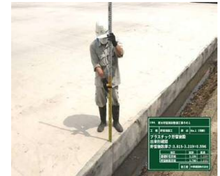
プラスチック貯留施設出来形確認
