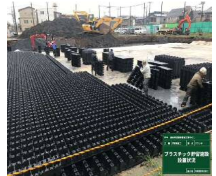
プラスチック貯留施設設置状況
