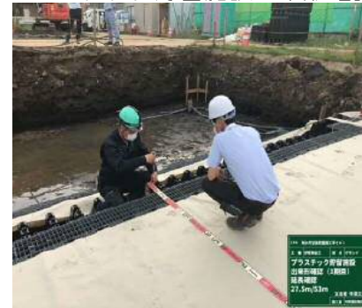
プラスチック貯留施設出来形確認
