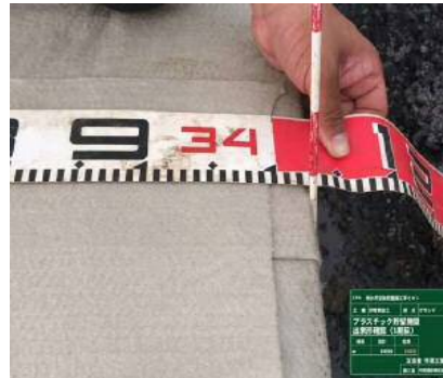
プラスチック貯留施設出来形確認
