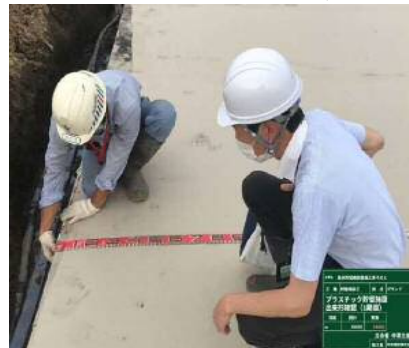
プラスチック貯留施設出来形確認
