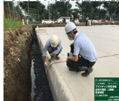
プラスチック貯留施設出来形確認
