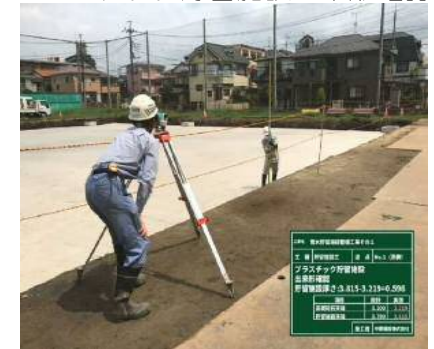
プラスチック貯留施設出来形確認
