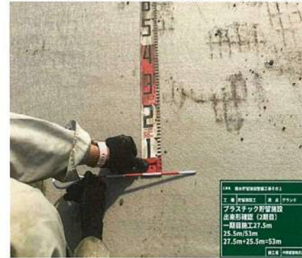
プラスチック貯留施設出来形確認
