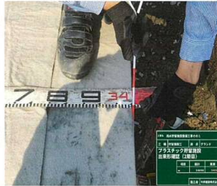
プラスチック貯留施設出来形確認
