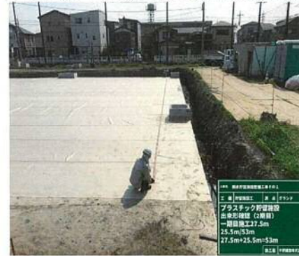
プラスチック貯留施設出来形確認
