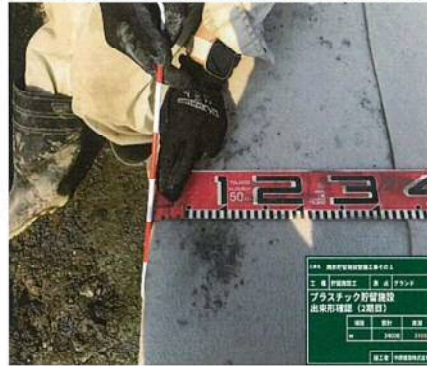
プラスチック貯留施設出来形確認
