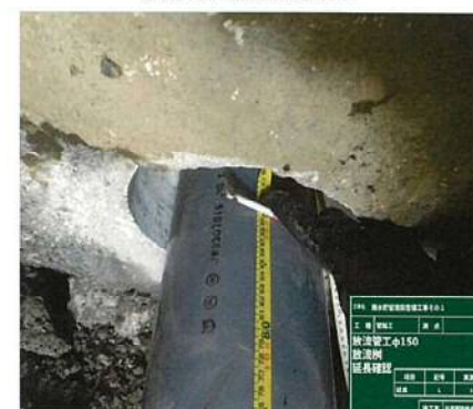
放流管接続完了
