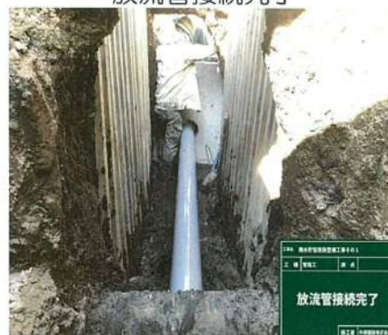
放流管接続完了
