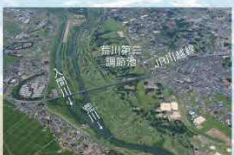
荒川第三調節池(整備中)
