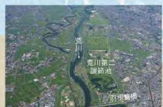
荒川第二調節池(整備中)
