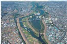
荒川第一調節池
