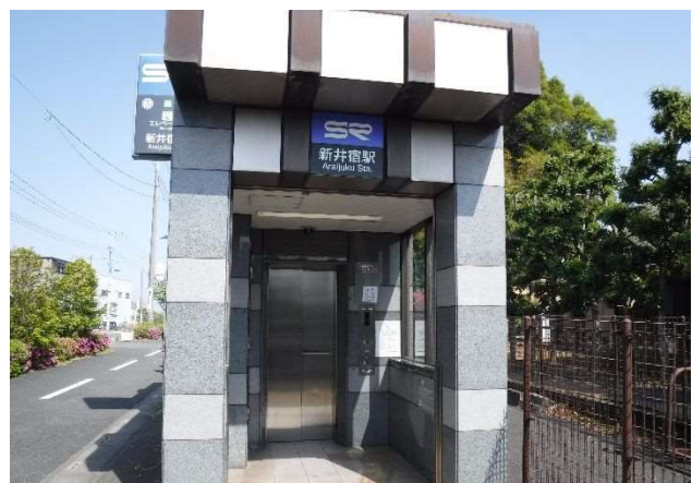
写真 3 : 新井宿駅出入口 (エレベーター)
