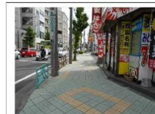
【5. 誘導用ブロック未設置】
