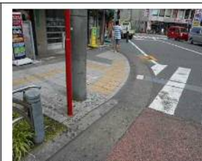
【11. 平坦部のない横断歩道接続部】
