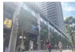
※令和5年3月竣工
