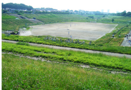
上谷沼調節池
