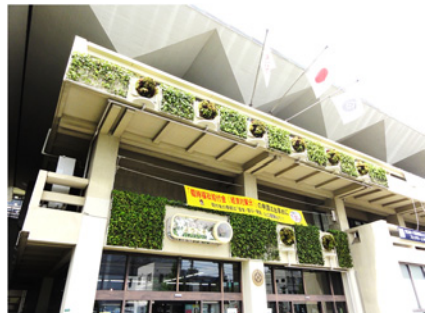
＜川口市役所本庁舎の壁面緑化*＞
