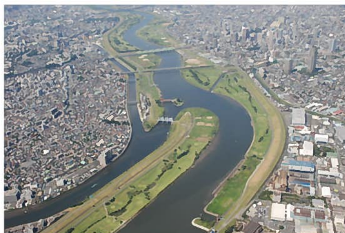
舟戸・河原町ブロック付近の荒川（19.7km～22.5km）〈平成21年撮影〉
