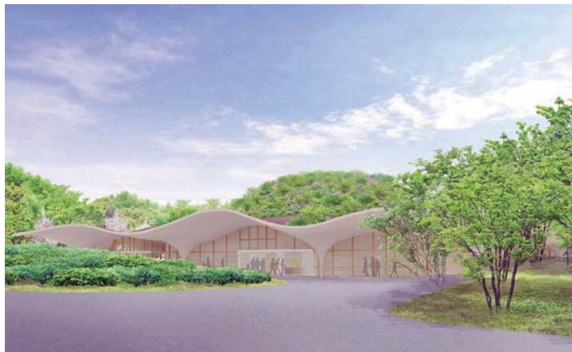
火葬施設外観
