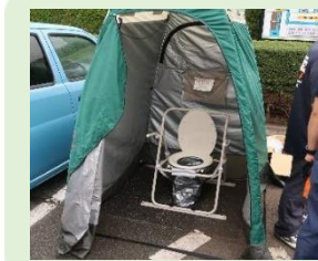
マンホールトイレ
