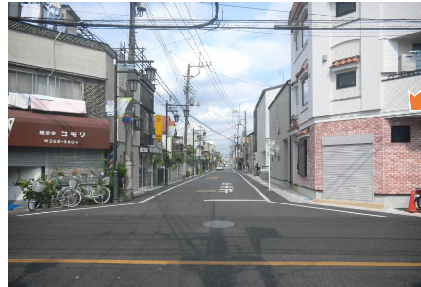
▲主要区画道路7号(整備後)
