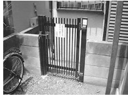
▲避難扉の設置により、行き止まり道路から逃げる事が可能になります。
