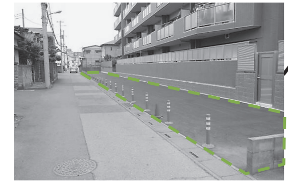
▲主要区画道路2号の道路用地
