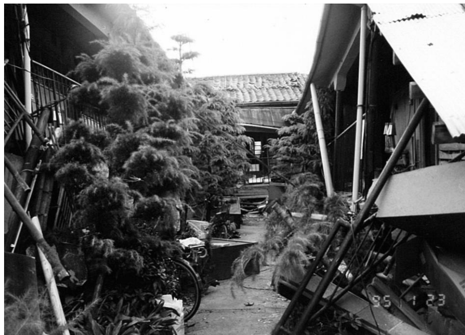
▲行き止まり道路沿いで倒壊した家屋（阪神・淡路大震災）
