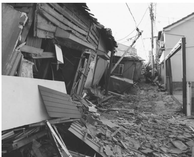
▲倒壊して道路を塞ぐ木造住宅（阪神・淡路大震災） 写真提供：神戸市
