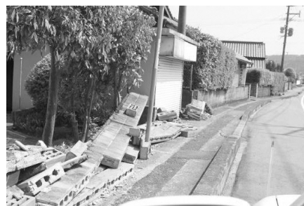
▲倒壊すると非常に危険です。
