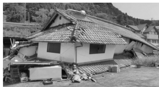
▲古い耐震基準の建物は倒壊しやすくなっています。
