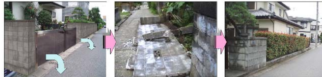
高い塀や門は地震の時など 生け垣にすることで、その危険性があります。 危険性もなくなります。
