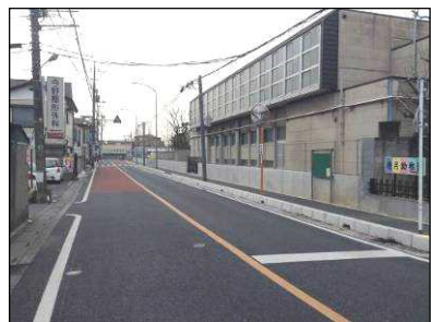
骨格道路(12号線)整備済み箇所
