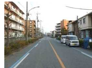
中層のまち並みの例
