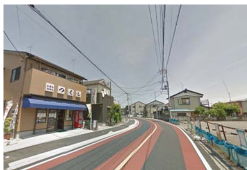
整備後（平成28年撮影）
