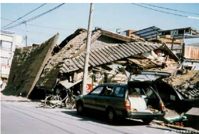
阪神・淡路大震災で倒壊した建物
