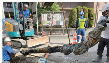
▲古い水道管を撤去し、新しい水道管へ交換しています
