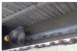
▲汚水管整備の様子
