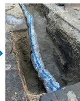
▲古い水道管を撤去し、新しい水道管へ交換しています
