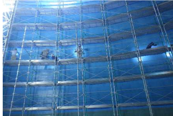
石神配水場第2配水池内部塗装工事
