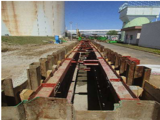
神根浄水場場内配管布設工事
