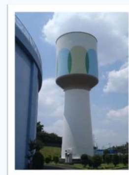
石神浄水場配水塔
