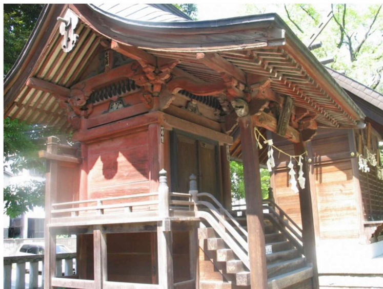
市指定有形文化財 八雲社社殿（旧金山権現社社殿）
