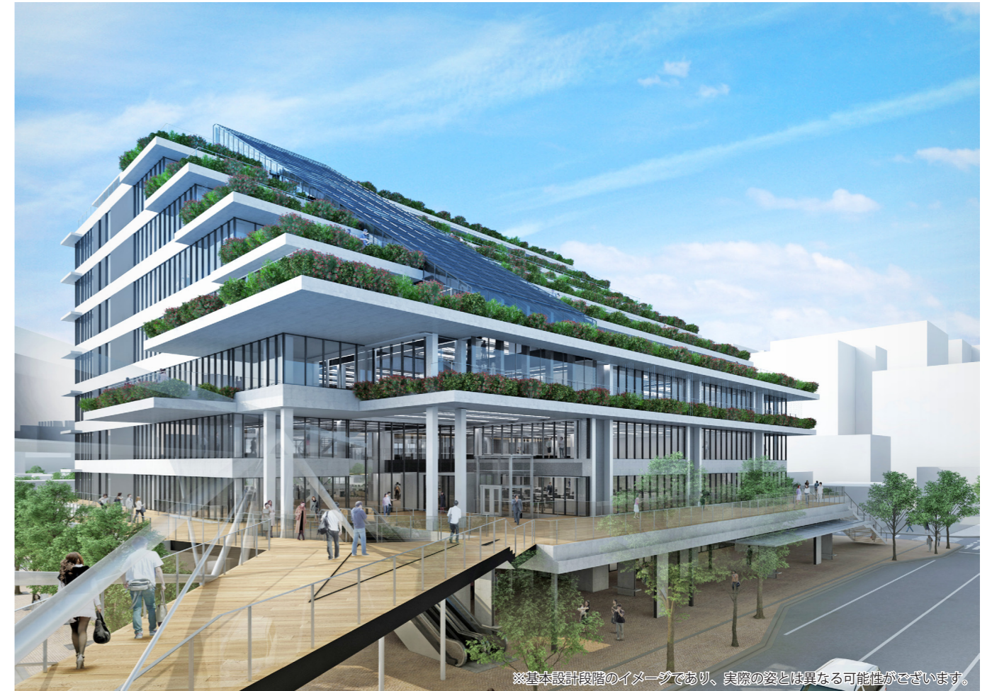
※基本設計段階のイメージであり、実際の姿とは異なる可能性がございます。 2期棟から見る1期棟の外観イメージ: 市役所前通りに対してセットバックするひな壇型庁舎。ペDESTリアンデッキが、新庁舎の周囲をぐるりと囲む。
