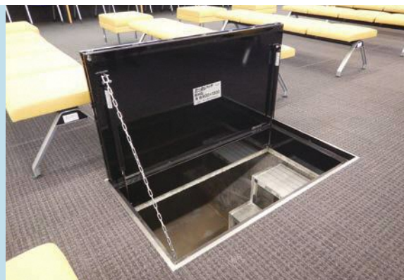
2階 床下「防災の蔵」入口
