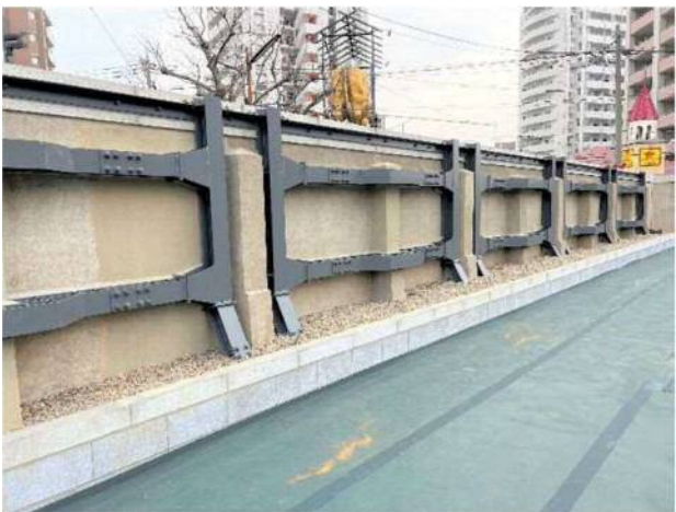
敷地側工事完了
