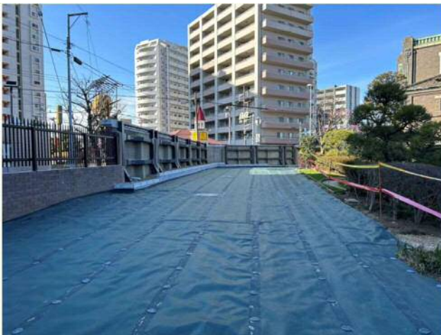
敷地側工事完了
