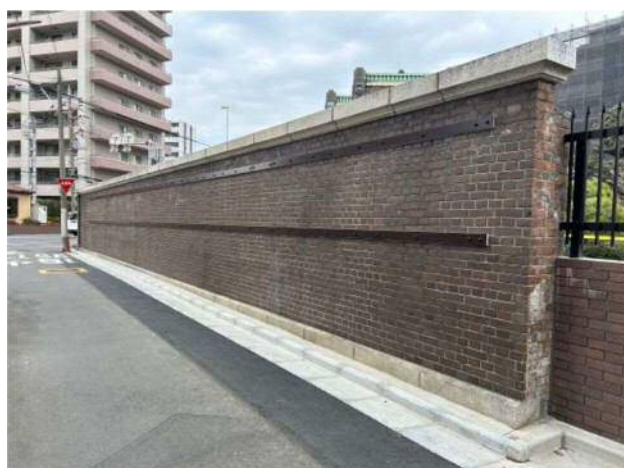
道路側工事完了（南道路側）
