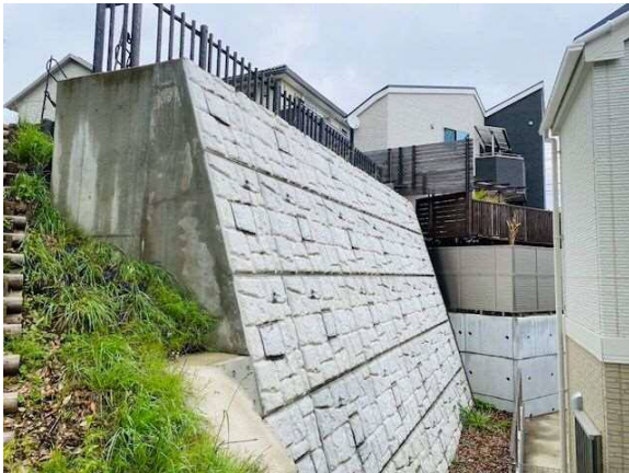
南側擁壁改修箇所（パンウォール工法）
