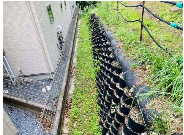
南側擁壁改修箇所（テラセル工法）
