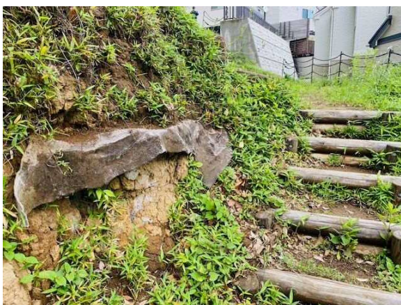
ジオグリッド工法排水シート露出箇所
