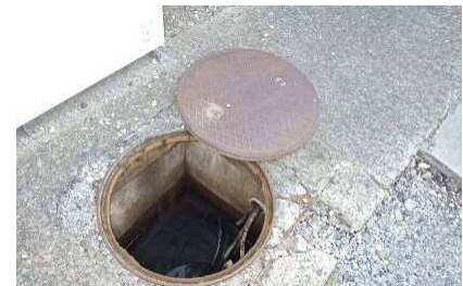
給食室外のマンホール内には、蚊発生の形跡なし
