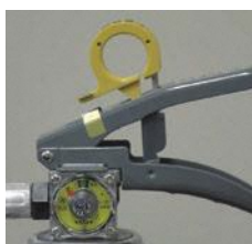
× 安全栓の抜けかけ
