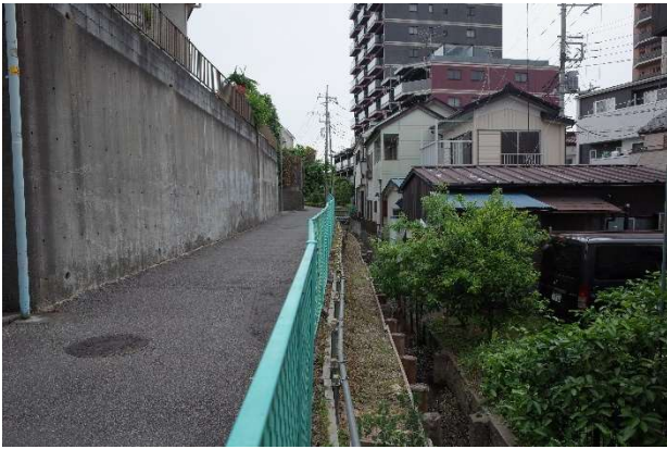
①主要区画道路A路線沿道の水路及び擁壁
