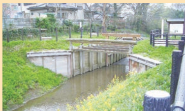
閘門式：舟を閘室(前後を扉で仕切った区画)に入れ、扉の開閉によって水位を昇降させ進路方向との水面を合せたのち、門を開いて舟を進める。 見沼通船堀：さいたま市緑区大字大間木地内
