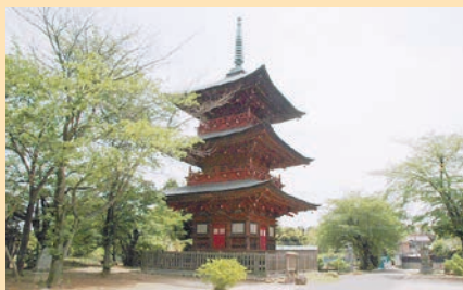
西福寺三重塔:元禄6年(1693)建立。県下で最も高い木造建造物(高さ23m)。所在地:補陀落山西福寺(川口市大字西立野420)
