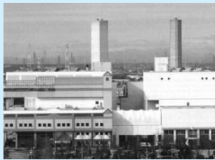
戸塚環境センター大規模改修
