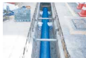
新しい下水道管の布設
