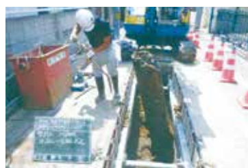
古くなった下水道管の撤去
