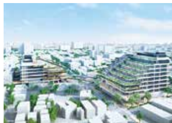
新庁舎2期棟建設
