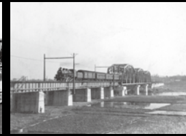
昭和3年ごろ 荒川鉄橋
