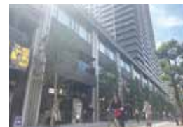
※令和5年3月竣工
