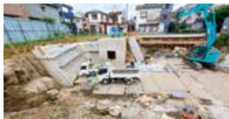
雨水貯留管、調節池等の整備 (平成25年度から23カ所を整備)
