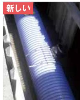
新しい管は従来の管(古いコンクリート管)と比べて汚水から発生する硫化水素の影響を受けにくく、管が損傷・破損するリスクが低くなっています。また、従来の管よりも耐震性・耐久性が高く、軽いため施工がしやすく、コスト面でも優れています。
