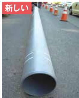
新しい管は従来の管(古い管)と比べて強度・耐久性が優れており、さらに管同士をつなぎ合わせている部分(継手)は耐震性が高い構造となっています。
