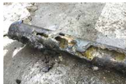
▲設置から44年が経過した水道管
